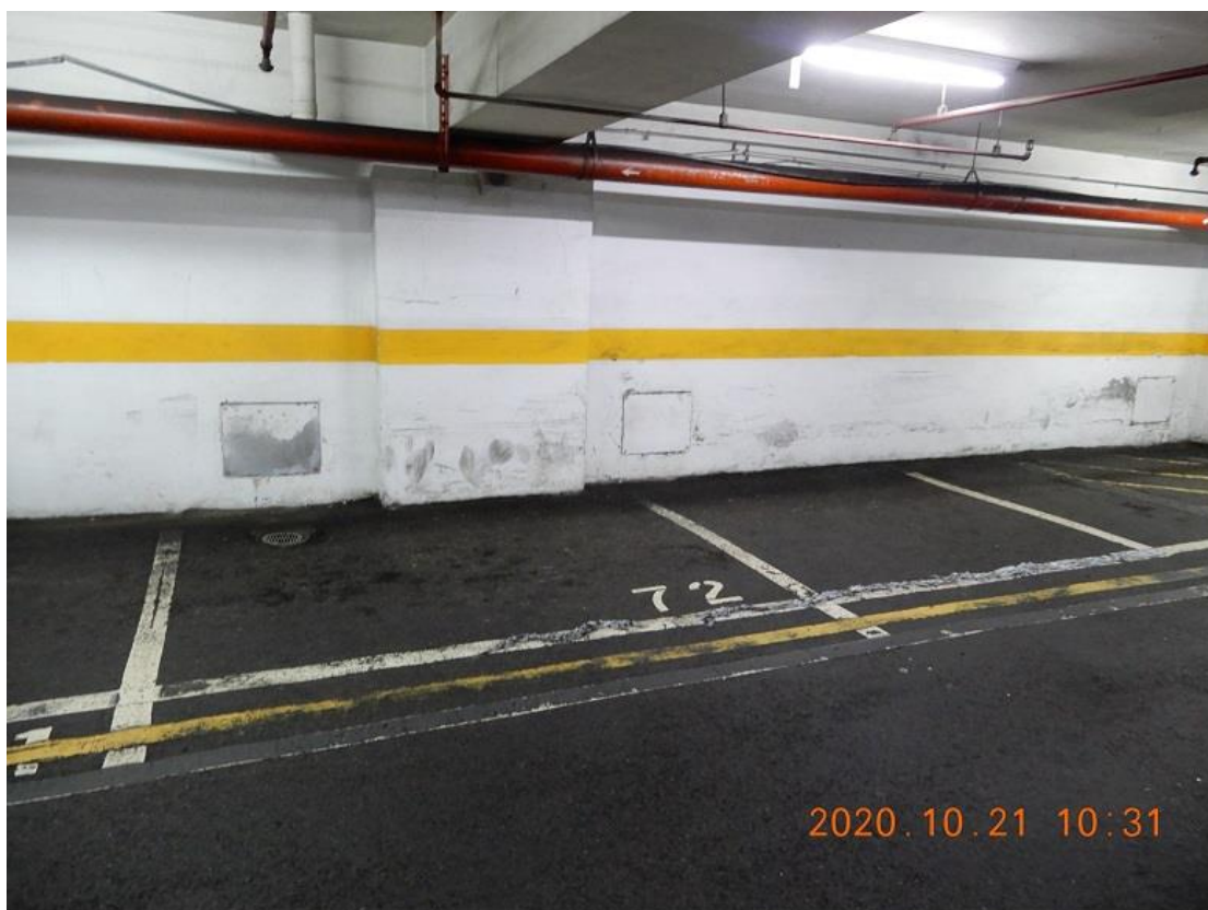
亞洲廣場大樓地下停車場
